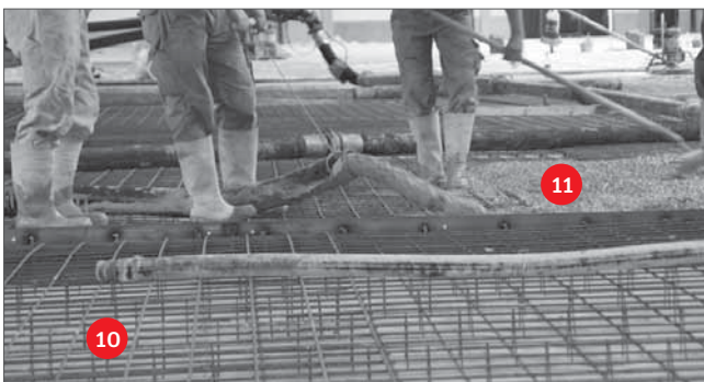
untere Bewehrung Roth Systemrohr Abstandhalter
