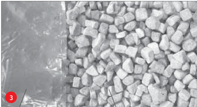
Abdeckfolie Wärmedämmung (hier: Foam-Glas)
